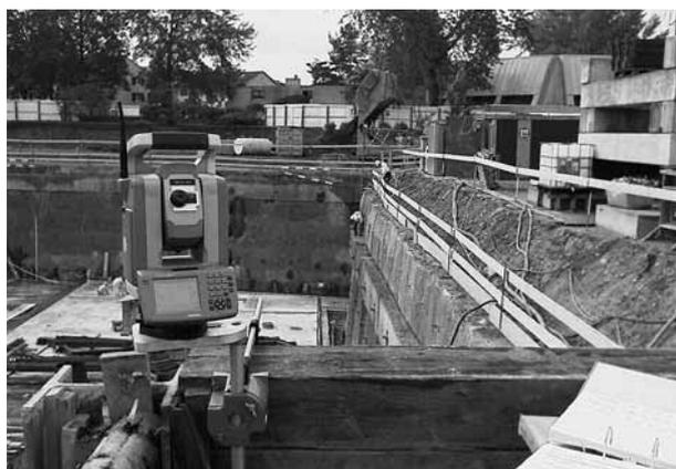
Überwachungsmessung Rühlwand, Baustelle Rosenberg
